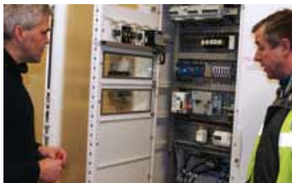
Technici controleren de sturing van de warmtekrachtkoppeling.
