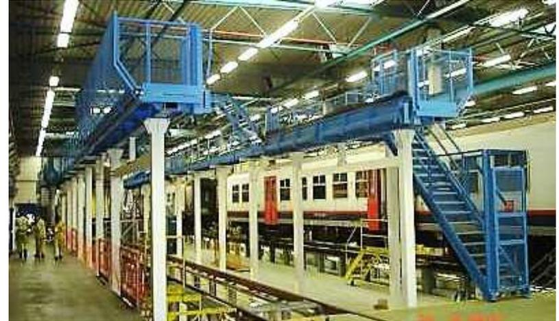
**Plateforme d'accès toiture dans le PET pour l'entretien des nouvelles automotrices DESIRO (0,7 Mio € en 2014)**
